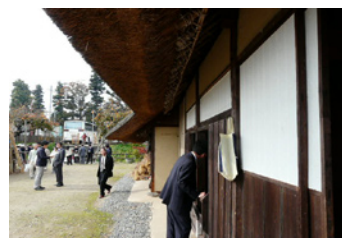
茅葺の深い軒。 雨かかりは板張りとしています
